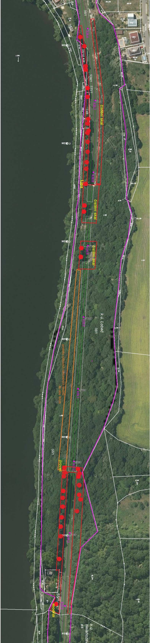
Železniční trať Praha - Děčín, úsek Kralupy nad Vltavou - Nelahozeves, žkm 438.6 - 439.410 , k.ú. Lobeč
